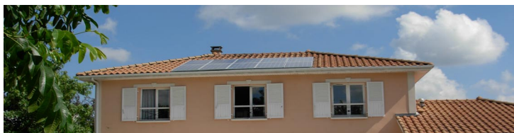
Installation solaire EVASOL chez un particulier Ce toit est désormais une source de revenus
